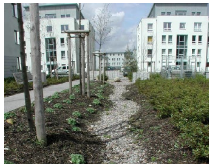
Principskiss för svackdike. Källa: VA-guiden. Exempel på makadamdiken. Källa: Norconsult
